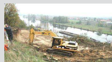
Děčínský portál – zahájení odtěžování 1. etáže. Děčín portal, beginning of excavation, the 1st stage.
