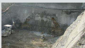
Děčínský portál – ochranný deštník z kotvě IBO. Děčín portal, protective umbrella in the top heading.
