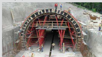
Pražský portál – betonáž prvního bloku délky 10 m. Prague portal, concreting of the 1st block, 10m long.
