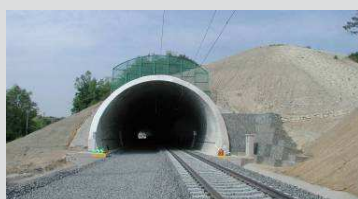
Děčínský portál – dokončena jedna kolej. Děčín portal, one track completed.
