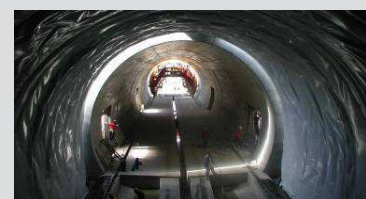
Rozhraní ražené a hloubené části tunelu. Joint of driven and cut-and-cover tunnel sections.
