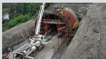
Děčínský portál – betonáž horní klenby. Děčín portal, concreting of the heading vault.
