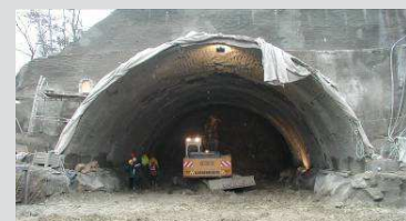
Zahájení ražby pod zábradím kaloty – 01/2001. Start of driving under canopy protection.
