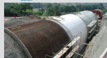
Pražský portál – betonáž horní klenby. Prague portal, concreting of the heading vault.
