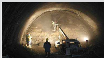
Provádění střihaného betonu. The primary lining shotcreting.
