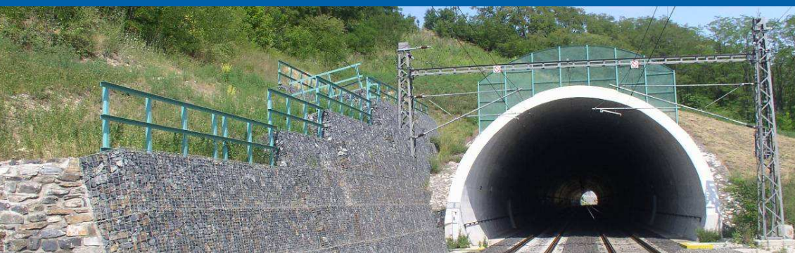
Dvoukolejný železniční tunel Vepřek na 1. železničním koridoru Praha – Děčín – Drážďany délky 390 m. Pražský portál po dokončení. Vepřek double-track tunnel on the 1st railway corridor Prague – Dresden, 390 m long, Prague portal after finishing.
