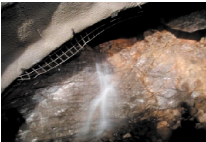
Obr. 6 Podzemní potok na čelbě tunelu Euerwang Fig. 6 Underground stream at the Eurwang tunnel face
