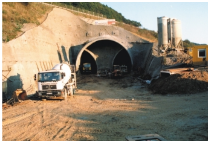
Obr. 5 Pohled na severní portál tunelu Irlahüll Fig. 5 A view of the Irlahüll tunnel North portal
