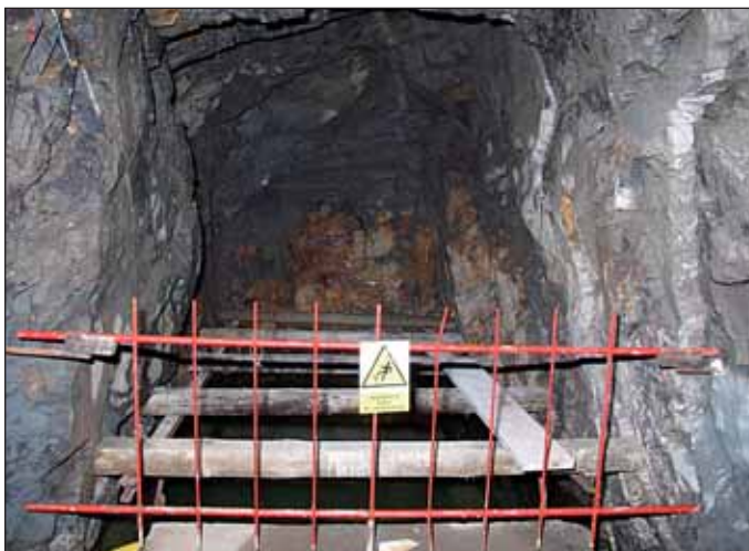
Obr. 4 Usazovací jímka ve štolě Fig. 4 Sump in the gallery
