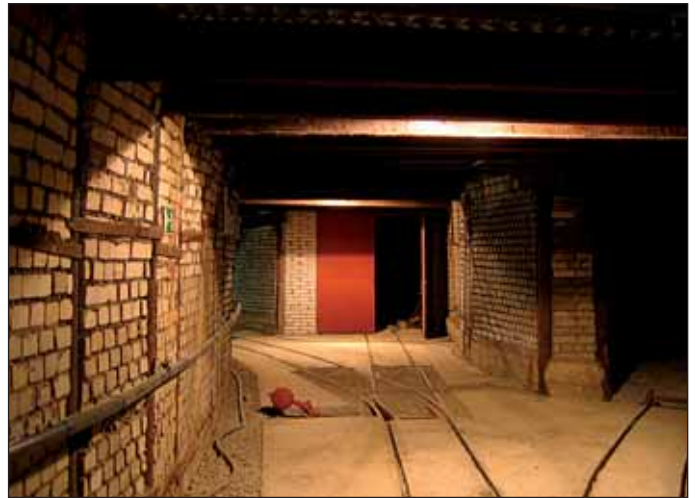
Obr. 7 Větrní vrata na překopu Fig. 7 Air-lock door of the cross-cut
