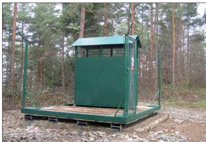
Obr. 8 Větrací objekt na ohlubení větracího komínu Fig. 8 Ventilation unit on vent shaft pit bank
