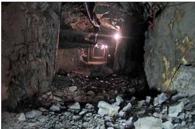
Obr. 6 Flexibilní lutny v překopu SCH-Z/SP 11 Fig. 6 Flexible pipes in the cross-cut SCH-Z/SP 11
