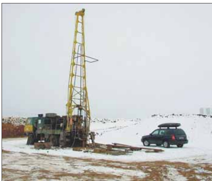
Foto 1 Ověřovací vrt délky 60 m Photo 1 Drill rig for core borehole
