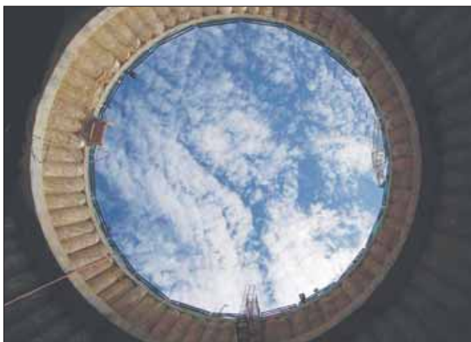
Foto 2 Ukázka výsledku vrtání pilot – pohled ze dna šachty Photo 2 Completed piles – view from the bottom of the shaft
