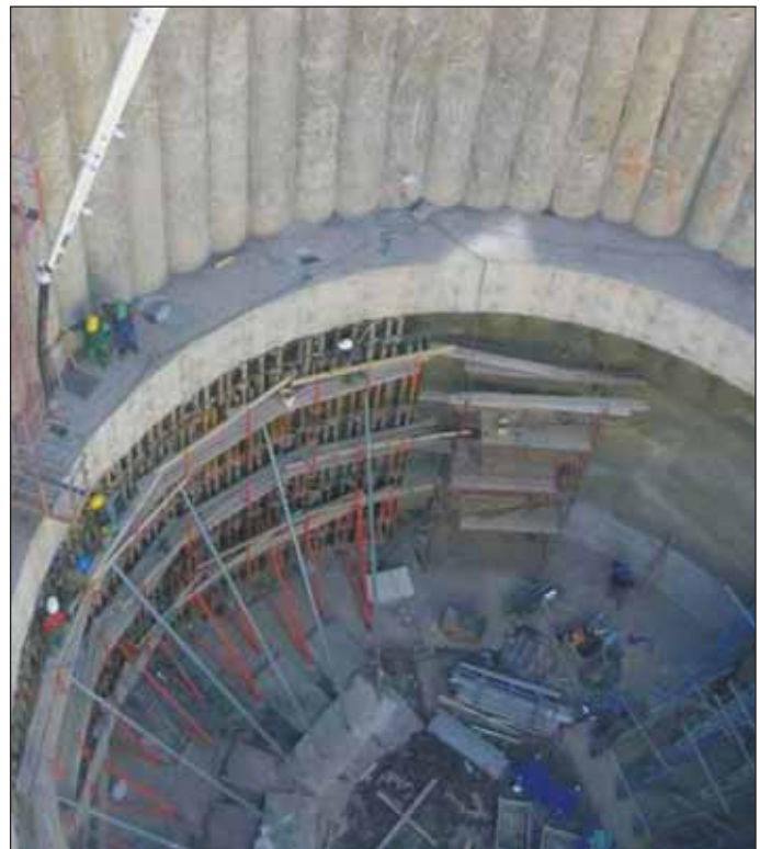
Foto 5 Betonáž ztužující stěny B samohutnícím betonem Photo 5 Casting of wall B by self-compacted concrete mix
