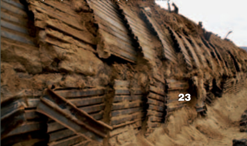
Obr. 5: Hnané pažení po obnažení rubu štoly – portál Komořany
