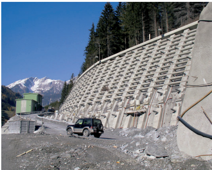
Obr. 3 Zajištění stability západního příportálového úseku tunelu Fig. 3 Support of the western pre-portal section of the tunnel
