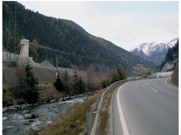
Obr. 8 Odtěžování drcené rubaniny dopravníkovým pásem unikátní konstrukce Fig. 8 Transportation of crushed muck by the unique-design belt conveyor
