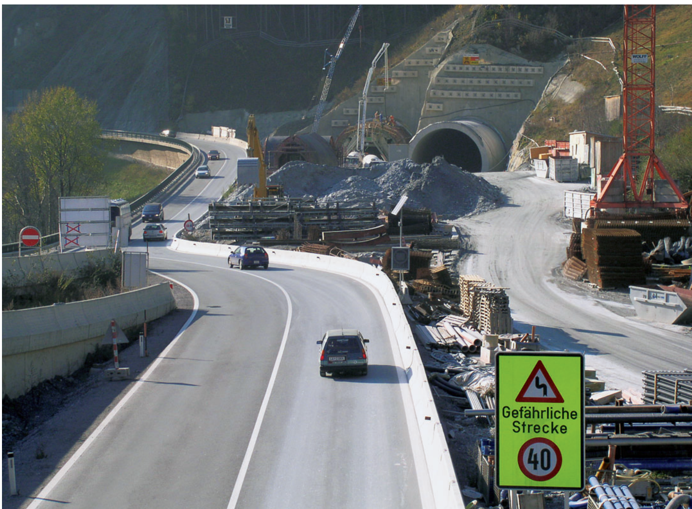
Obr. 9 Východní portál a stávající komunikace Fig. 9 Eastern portal and existing road
