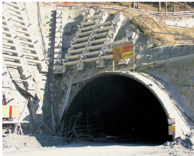
Obr. 4 Zajištění stěny západního portálu Fig. 4 Support of the western portal wall
