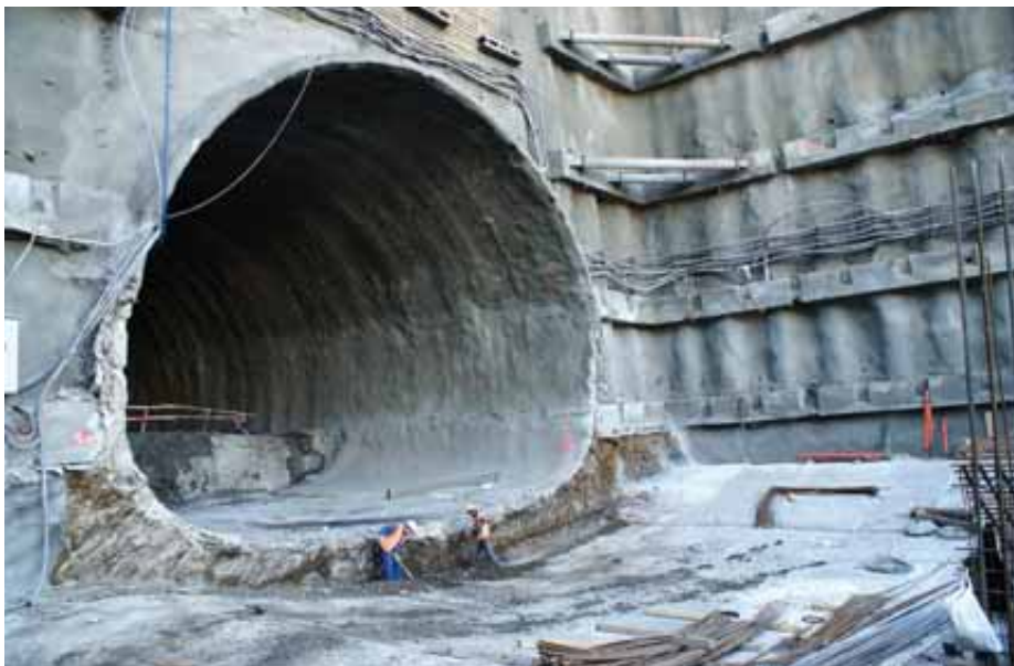
Obr. 11: Primární ostění se spodní klenbou – plocha výrubu 165 m 2
