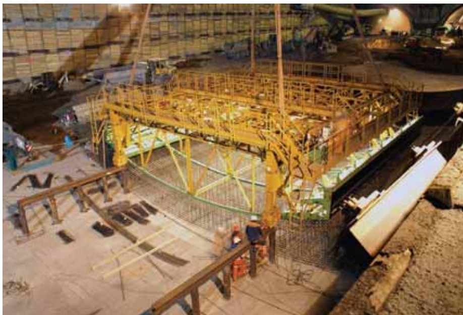
Obr. 8: Speciální bednění spodní klenby hloubených tunelů Komořany
