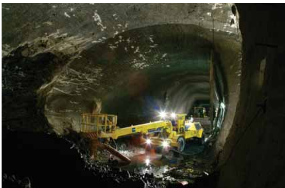
Obr. 13: Rozšiřování štoly v místě výhybny – zahájení ražby
