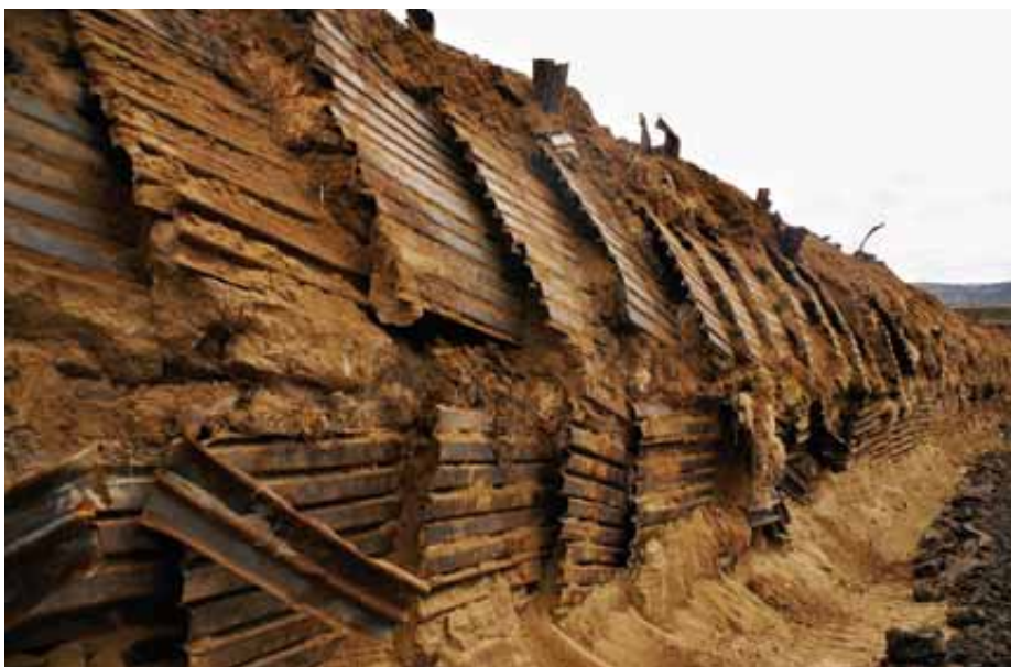
Obr. 7: Hnané pažení po obnažení rubu štoly – portál Komořany
