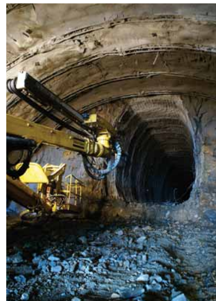
Obr. 3: Průzkumná štola situovaná ve středu kaloty jižního tunelu
