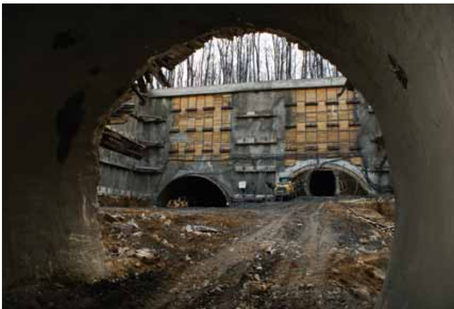
Obr. 6: Horninový pilíř mezi tunely – pohled z demolované průzkumné štoly
