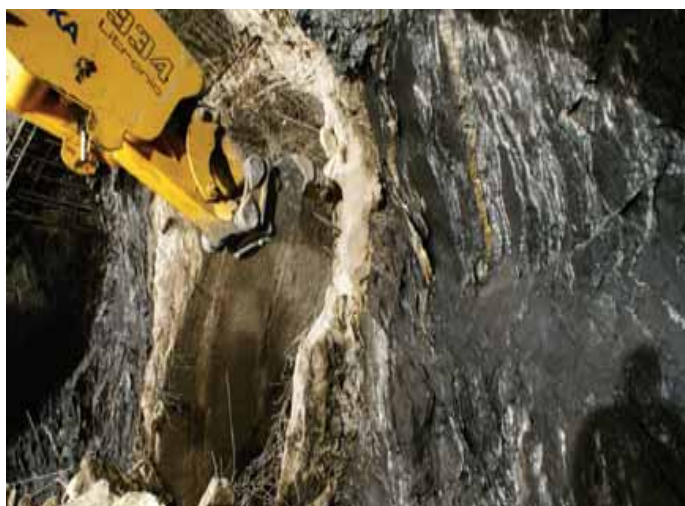
Obr. 4: Sklon diskontinuit na čelbě kaloty jižního tunelu
