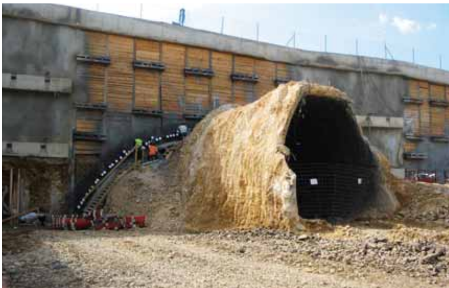
Obr. 10: Zbytek ostění průzkumné štoly a mikropilotový deštník – portál Cholupice
