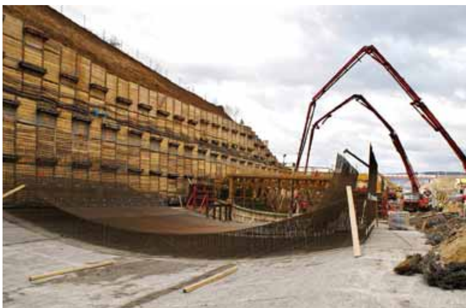
Obr. 9: Upravená základová spára hloubených tunelů
