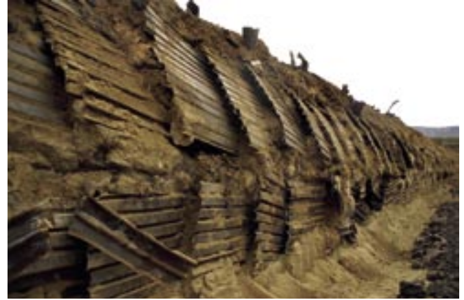
Obr. 3 Hnané pažení po obnažení ostění průzkumné štoly
