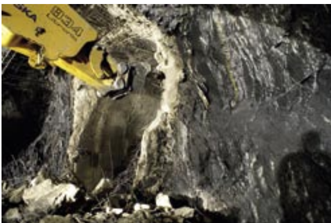
Obr. 4 Sklon diskontinuit na čelbě kaloty jižního tunelu
