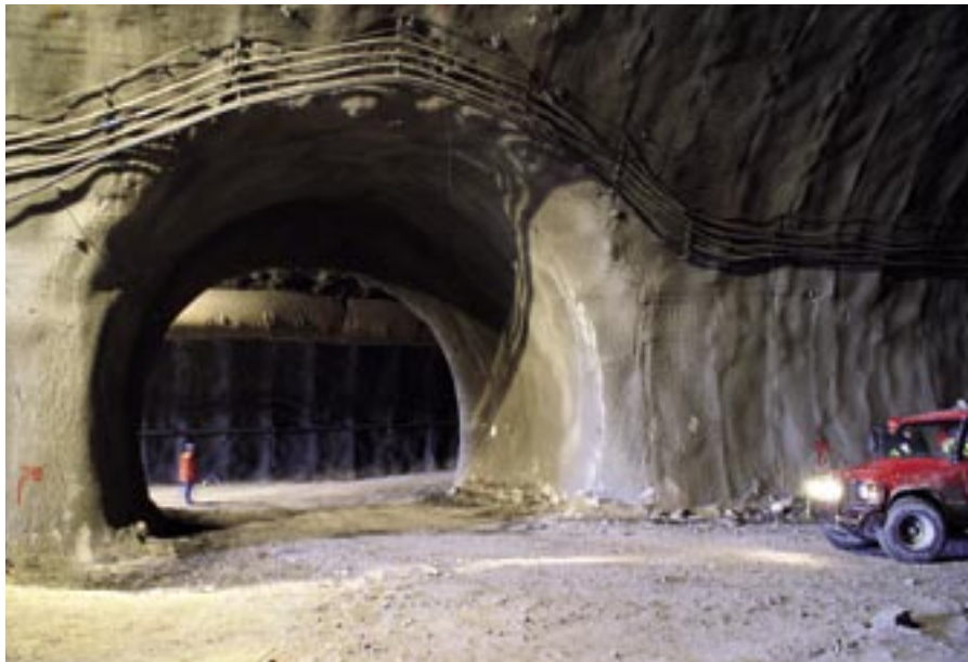
Obr. 6 Minimální šířka horninového pilíře u propojky č. 1
