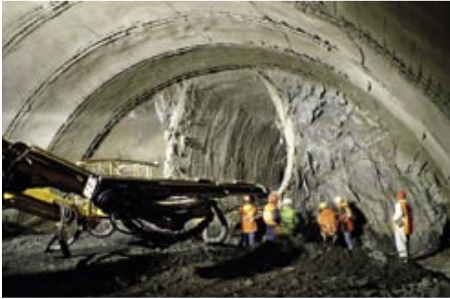
Obr. 2 Průzkumná štola situovaná ve středu kaloty jižního tunelu
