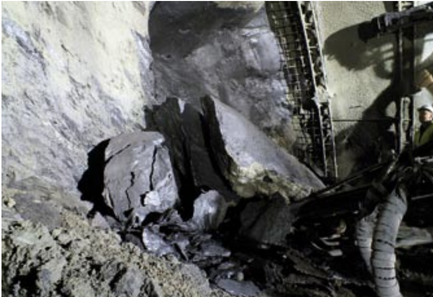
Obr. 7 Nestabilita čelby při nepříznivém sklonu puklin
