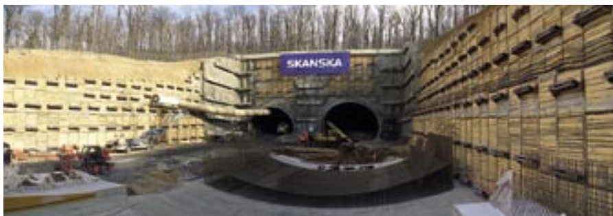
Obr. 1 Stavební jáma Komořany
