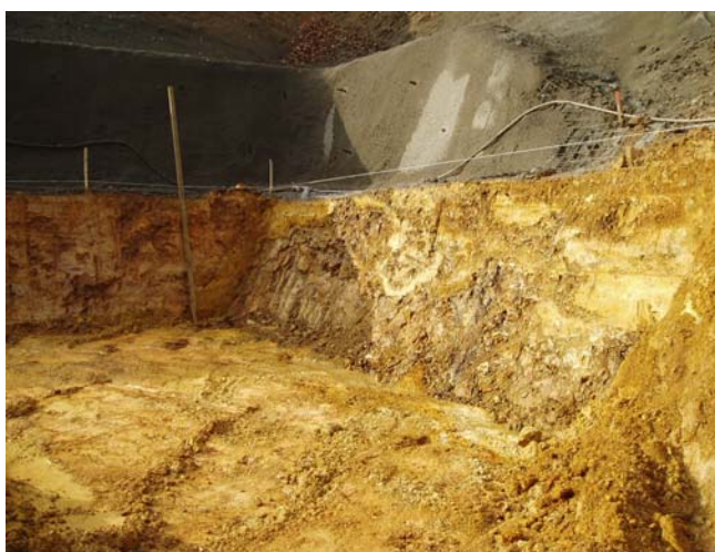
Obr. 1 Jižní portál východního tunelu – zóna zvětrání zasahuje až do úrovně kaloty
