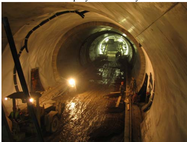
Obr. 3 Šachovnicový způsob betonáže definitivního ostění pro omezení vzniku trhlin
