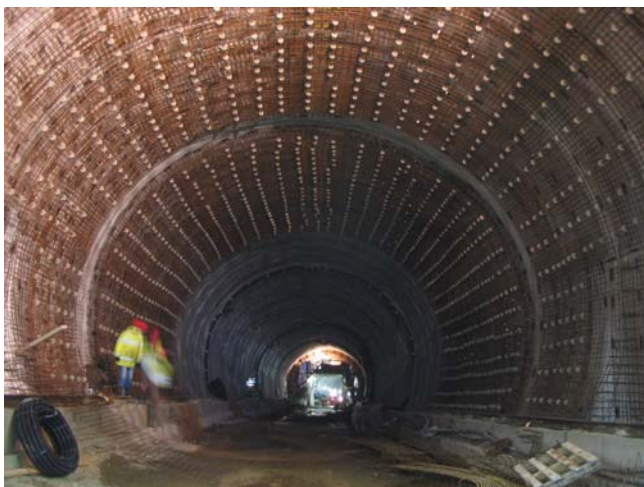
Obr. 2 Samonosná výztuž příportálových ražených úseků tunelu
