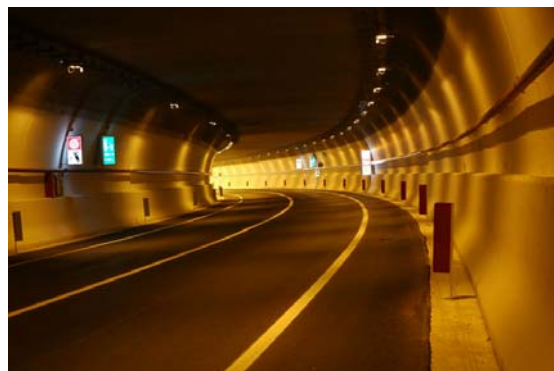
Obř. 6 Tunel Monte Cuneo po dokončení
