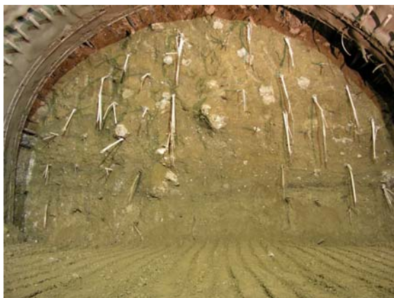
Obr. 2 Zajištění čelby dle ADECO-RS
