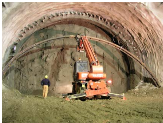
Obr. 5 Osádzanie oblúkového nosníka
