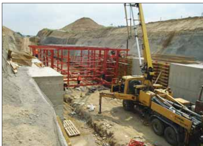
Obr. 4 Speciální bednění bočních klínů (06/2010) Fig. 4 Special formwork for side wedges (06/2010)
