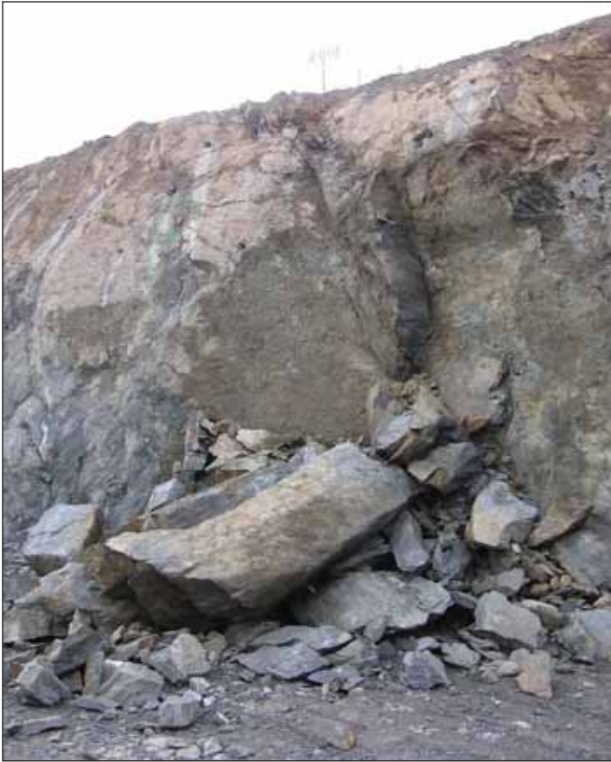
Obr. 2 Uvolněné skalní bloky (04/2010) Fig. 2 Loosened rock blocks (04/2010)
