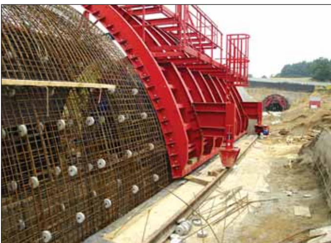
Obr. 12 Vnější bednění Fig. 12 Outer formwork
