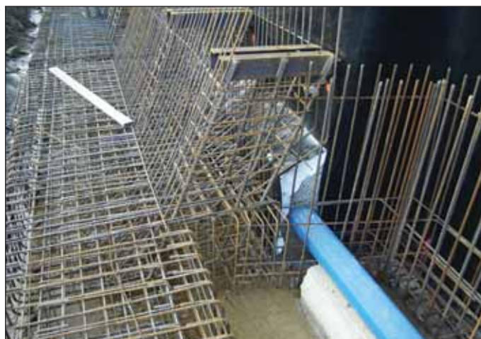
Obr. 9 Boční tunelová drenáž Fig. 9 Tunnel side drainage
