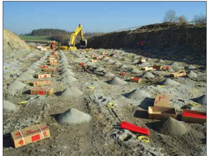
Obr. 6 Rozpojování trhavinami (04/2010) Fig. 6 Disintegration by means of explosives (04/2010)
