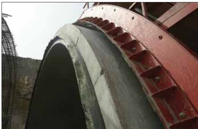
Obr. 10 Spárový pás Fig. 10 Waterstop
