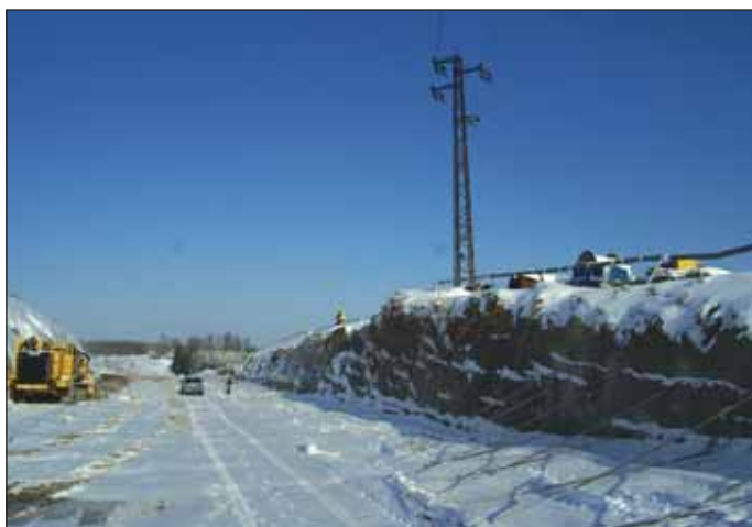
Obr. 8 Stožár VN na hraně jámy Fig. 8 High-tension line pole at the pit edge
