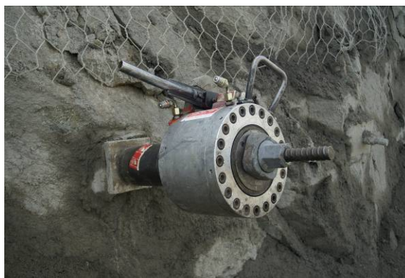
Obr. 16 Zkoušení celozávitových předpjatých kotev
