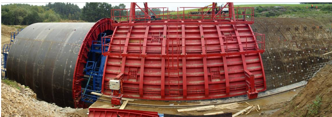
Obr. 23 Pojízdné vnitřní, vnější bednění a smontovaná samonosná výztuž
