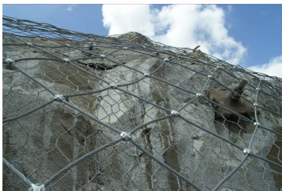
Obr. 15 Stabilizace svahu HEA panely
