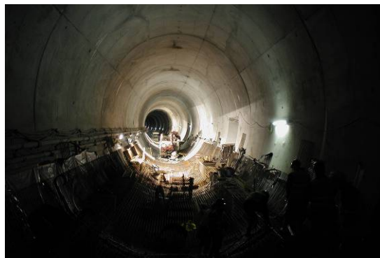
Obr. 12 Vodonepropustné ostění tunelu Leinzer
