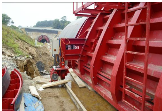
Obr. 22 Pojezd vnějšího bednění na první lavici
