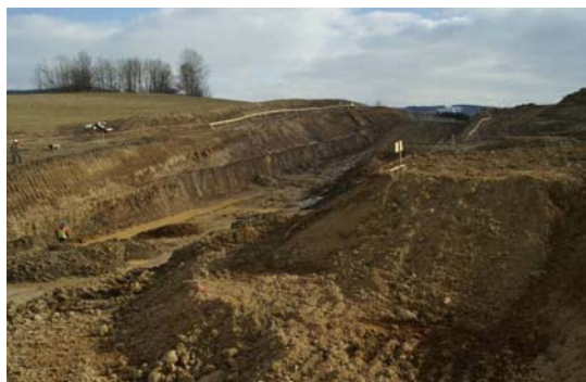
Obr. 5 Celkový pohled na stavební jámu v oblasti výjezdového portálu
