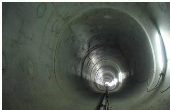
Obr. 11 Vodonepropustné ostění metra ve Vídni
