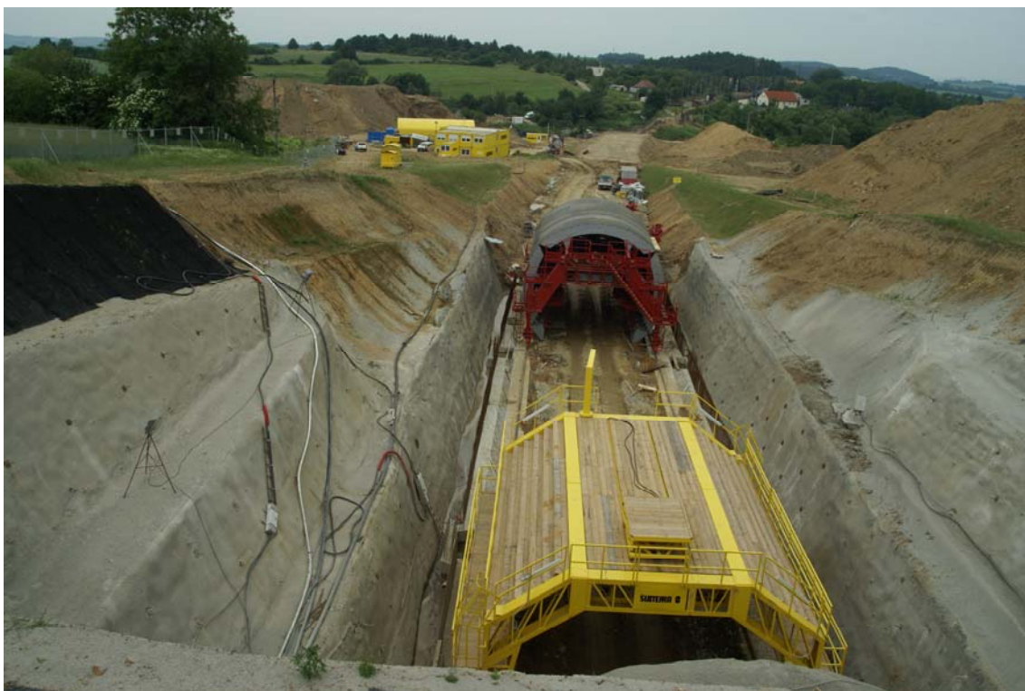
Obr. 1 Svahovaná stavení jáma Olbramovického tunelu – výjezdový portál
