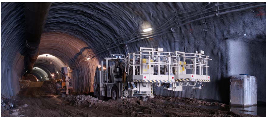
Obr. 4 – Primární ostění Olbramovického tunelu, členění výrubu, vlevo rampa do kaloty
