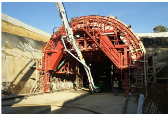
Obr. 5 Bednicí vůz hloubených tunel se speciálním čílkem pro vložení tesnicího pásu
