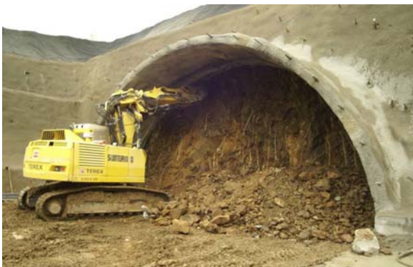
Obr. 2 Výjezdový portál Olbramovického tunelu – hornina se úlomkovitě rozpadá, čelba je stabilní
