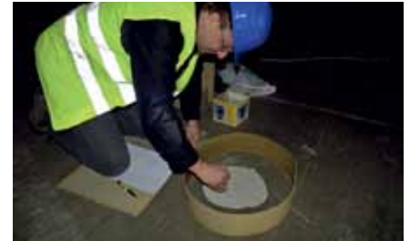
Obr. 6 Měření hloubky zdrsnění vozovky
