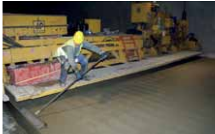
Obr. 5 Ruční zdrsnění povrchu vozovky
