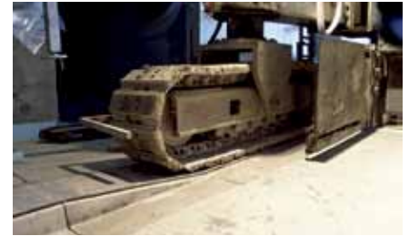
Obr. 4 Snižování chodníku v místě tunelové propojky
