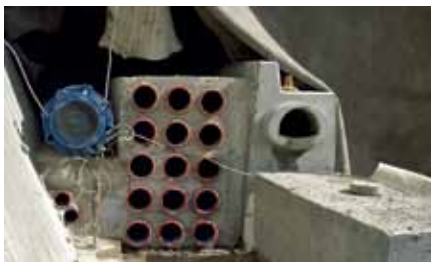
Obr. 7 Umístění chrániček v kabelovodu
