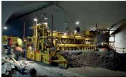
Obr. 3 Betonáž vozovky v místě nouzového zálivu
