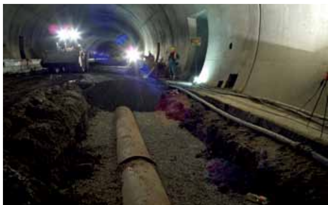
Obr. 1 Umístění kanalizace v blízkosti patky ostění
