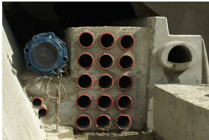
Obrázek 7. Kabelovod a požární vodovod třípruhového tunelu
