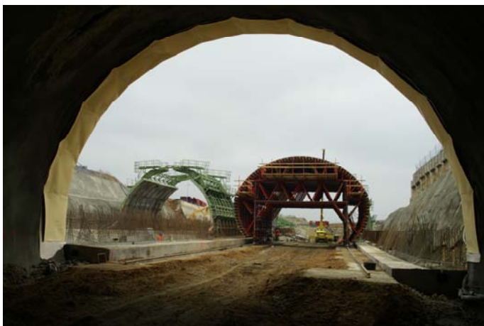
Obrázek 10. Vnější (vlevo) a vnitřní (vpravo) bednění tunelu
