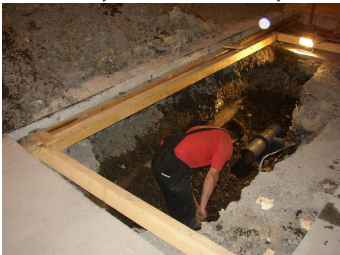
Obrázek 8. Oprava potrubí požárního vodovodu pod vozovkou
