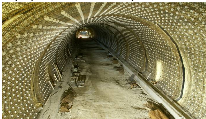
Obrázek 9. Samonosná výztuž definitivního ostění
