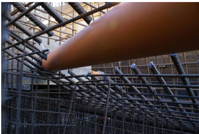
Obrázek 6. Přerušování výztuže v místě drenáže
