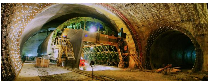
Obrázek 11. Bednicí vůz v místě nouzového zálivu
