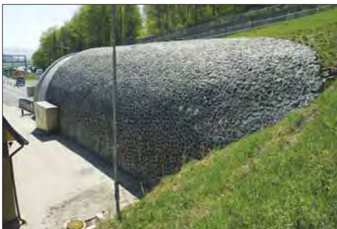
Obr. 6 Obklad jednostranně obnaženého portálového bloku tunelu Libouchec Fig. 6 Cladding of the exposed side of the Libouchec tunnel portal block
