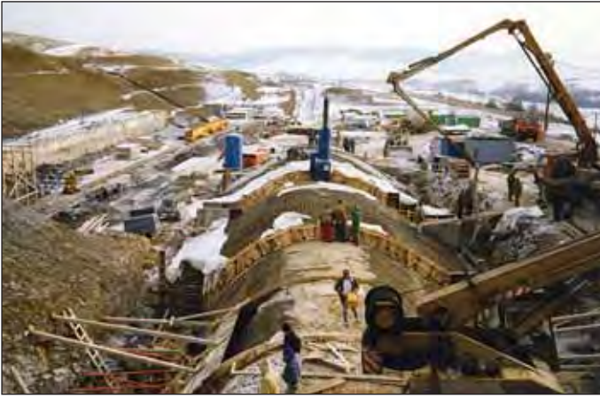
Obr. 16 Klimatické poměry při betonáži želvy na tunelu Branisko Fig. 16 Climatic conditions during the casting of the Branisko tunnel tortoise shell
