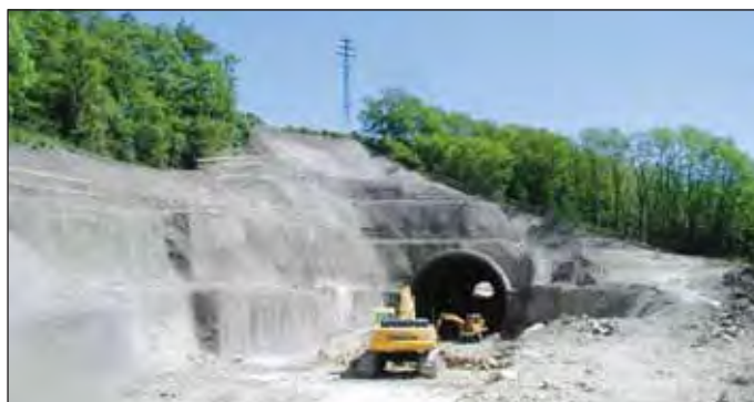
Obr. 1 Asymetrická stavební jáma tunelu Vepřek Fig. 1 Asymmetric construction trench – the Vepřek tunnel
