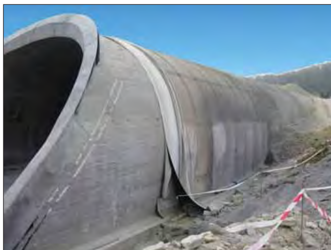
Obr. 10 Ochrana hydroizolace stříkaným betonem Fig. 10 Protection of the waterproofing with shotcrete
