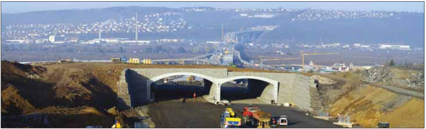
Obr. 12 Kompletní zásyp hloubeného tunelu Fig. 12 Complete backfill of a cut-and-cover tunnel
