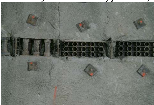
Obr. 2 Deformační prvky v primárním ostění
