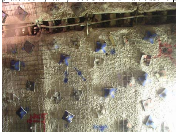
Obr. 1 Kotvení pro zajištění stability výrubu
