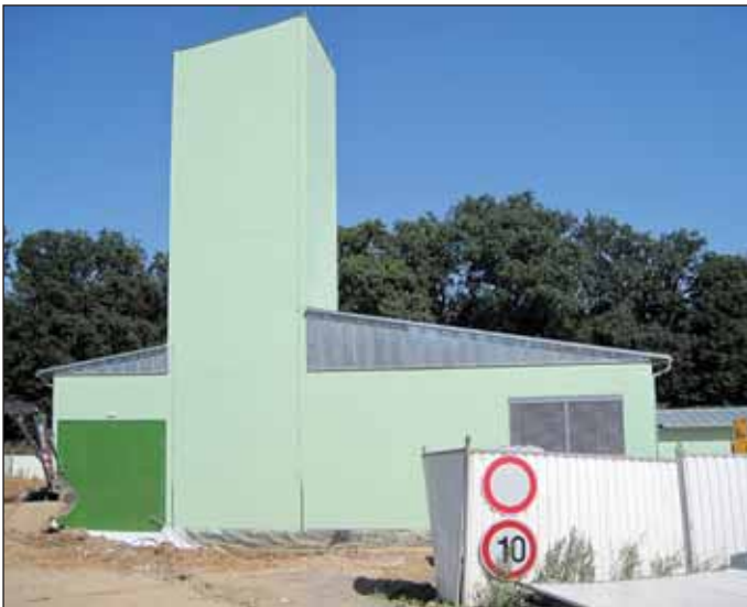
Obr. 14 Nadzemní část vzduchotechnického objektu Fig. 14 Above ground part of the ventilation structure
