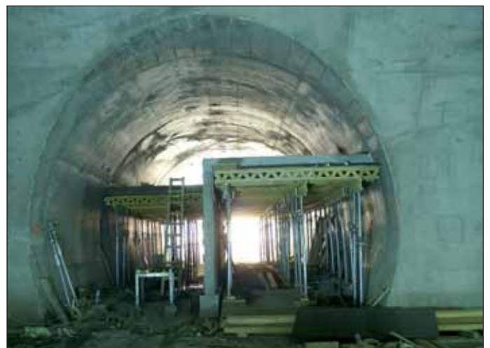
Obr. 7 Betonáž mezistropu v propojce č. 5
