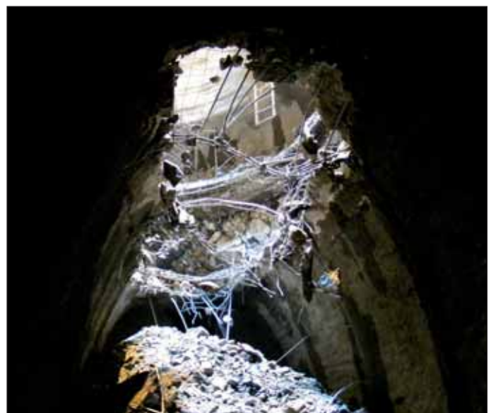
Obr. 9 Prorážka šachty do přístupové štoly Fig. 9 Shaft breakthrough into the access adit
