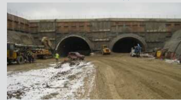
Stavební jáma cholutického portálu. Excavation pit of the Cholutice portal.
