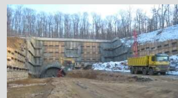
Stavební jáma komořanského portálu. Excavation pit of the Komořany portal.
