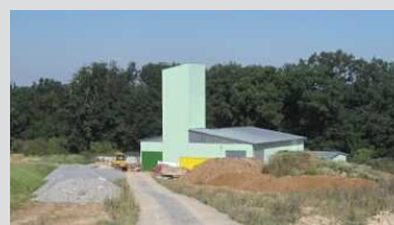
Vzduchotechnický objekt Nouzov. Ventilation headhouse Nouzov.
