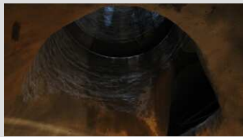
Primární ostění vzduchotechnické šachty. Ventilation shaft primary lining.
