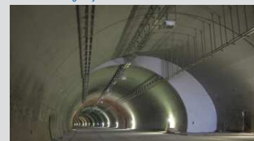
Přechod ze čtyřpruhového hloubeného tunelu na ražený třípruhový tunel. Change-over from cut-and-cover four-lane tunnel to driven three-lane tunnel.
