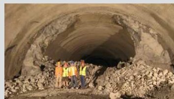
Prorážka severního dvoupruhového tunelu 7.8.2008. Breakthrough of northern two-lane tunnel Aug. 7th 2008.
