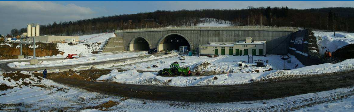
Portál Komořany s přeložkou komunikace nad tunely a budovou PTO (provozní technologický objekt). Komořany portal with road by-pass over tunnel portals and M&E building.
