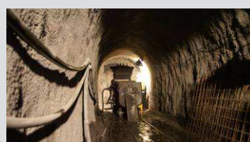
Ražba kanalizační štoly. Driving of the rainwater outlet tunnel.
