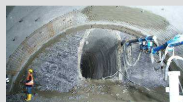
Geotechnické podmínky v kalotě třípruhového tunelu. Geotechnical conditions in the top heading of the three-lane tunnel.
