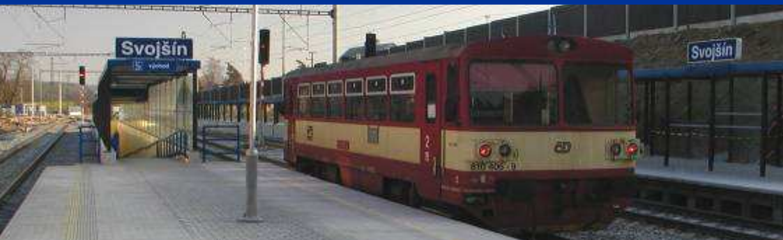
Podchod v žst. Svojšín – pohled z nástupiště na výstup rampy podchodu
