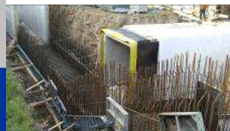
Výztuž výstupních ramen
