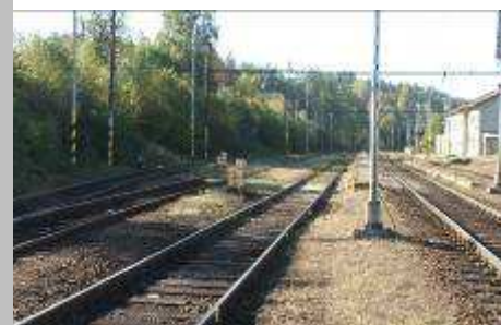
Pohled na původní stav nádraží
