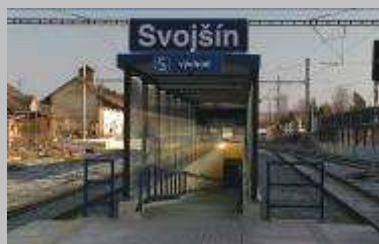
Pohled na výstup rampy
