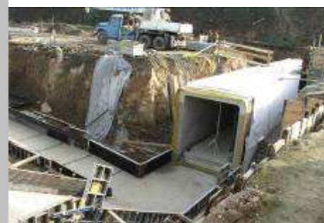
Betonáž tubusu podchodu
