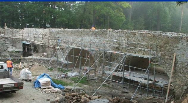
■ Návodní strana mostu v průběhu opravy
