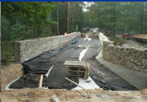
■ Stav před pokládkou izolačního systému
