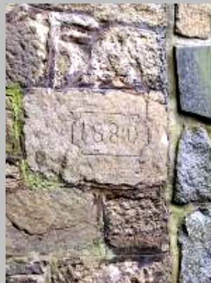
■ Datování stavby na opěře klenby nad přepadem
