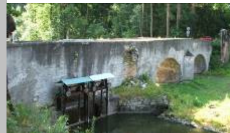
■ Návodní strana mostu- původní stav
