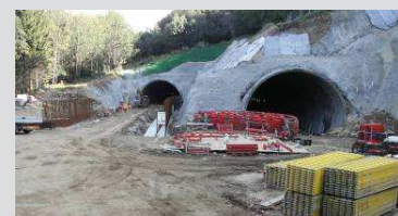
Severní portál, portály ražených tunelů. The northern driven tunnel portals.
