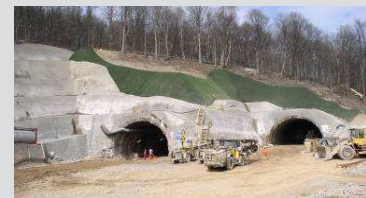
Jižní portál, portály ražených tunelů. The southern driven tunnel portals.
