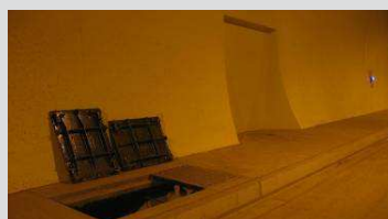
Kabelová šachta a výklenek pro čištění drenáže. The cable shaft and niche for drainage cleaning.
