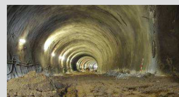
Dokončené primární ostění. Final stage of the primary lining.
