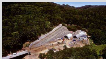
Letecký pohled na jižní portál. Aerial view of the southern portal.
