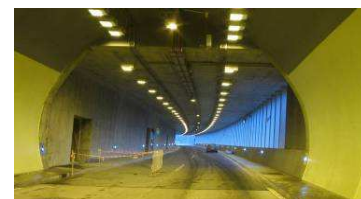
Přechod z tunelu do galerie. Tunnel passing into the gallery.
