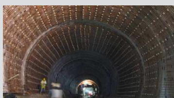
Vyztužené ostění je pouze v příportálových úsecích. Reinforced final lining is used only in parts next to the portals.
