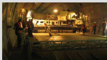
Kontinuální betonáž vozovky. Continual installing of the concrete road.
