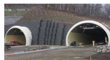
Gabionová zeď na jižním portále. Gabion wall in the southern portal.
