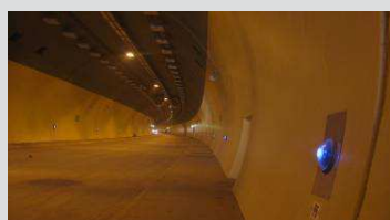
Nouzové osvětlení ve výšce 0,9 m nad chodníkem. The emergency lighting, 0,9m above the sidewalk.
