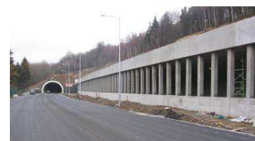
Galerie délky 160 m na severním portále. Gallery in the northern portal, 160m long.
