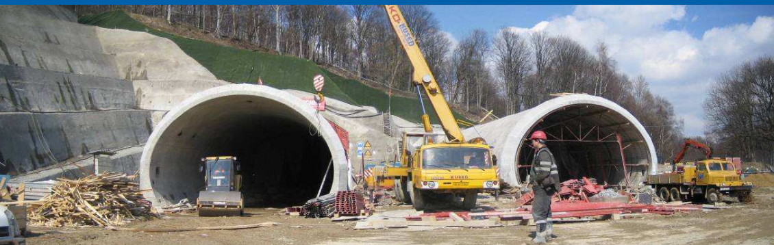
Dálniční tunel Libouchec, dálnice D8 Praha - Drážďany, délka západní roury 520 m, délka východní roury 492 m. Dokončené hloubené úseky na jižním portále. Libouchec highway tunnel, D8 highway Prague – Dresden, western tunnel tube is 520m long, eastern tunnel tube is 492m long. Final stage of the cut-and-cover tunnels on southern portal.
