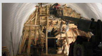
Bedňení čela tunelové propojky. Formwork in the face of cross passage.
