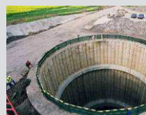
Šachta. Primární konstrukce. The Shaft. Primary structures.
