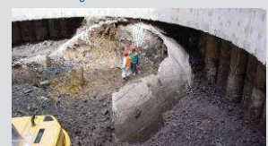
Rub tunelového ostění a poslední čelba. Tunnel lining back and last tunnel face.
