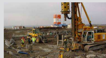
Vrtání převrtávaných pilot. Drilling of the secant piles.
