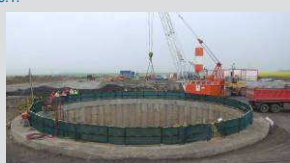
Převázka č. 1 s ochranným zábradlím. Ring beam No. 1 with safety railing.
