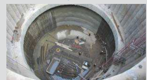
Vázání výztuže ztužujících stěn. Reinforcing of concrete walls.
