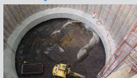
Zbýlé předkleby a vršek Perforexu. Remaining vaults and the top of Perforex.
