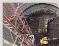
Hloubení kolem zavaleného stroje. Excavation around the buried machine.
