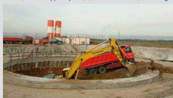
Počátek hloubení. Start of the excavation.
