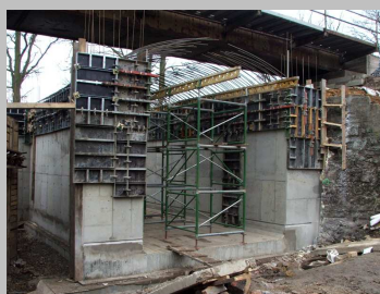
Podjezd „U Chaloupek“ - stavba pod provizoriem
