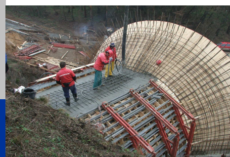
Betonáž podjezdu do Hracholusek
