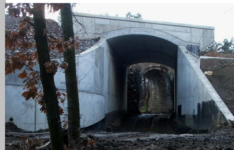
Nový podjezd u Plešnice pro lesní komunikaci
