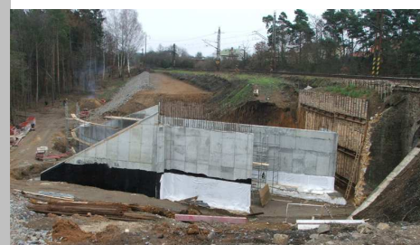
Nový podjezd u Plešnice pro lesní komunikaci - zajištění stavební jámy
