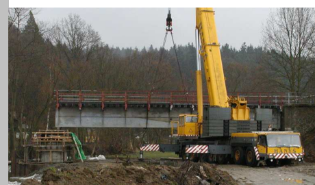
Osazování mostní konstrukce
