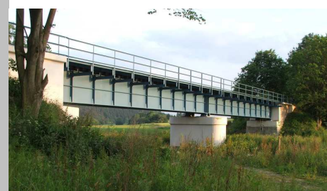
Pohled na most z návodní strany
