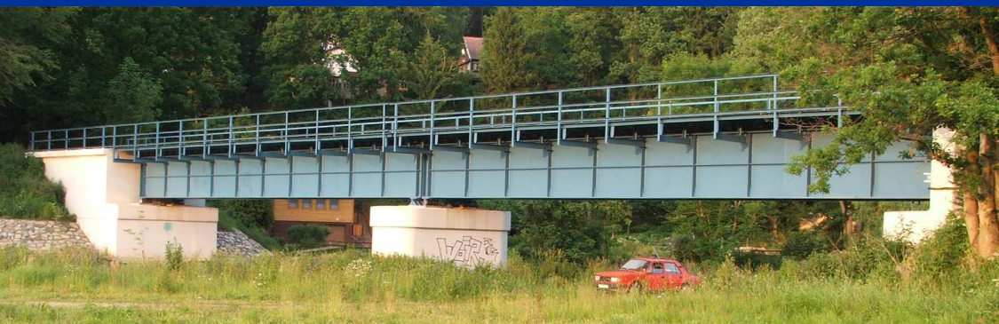
Pohled na most z povodní strany
