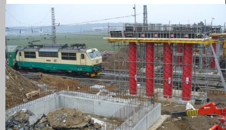
Rozestavěný nadjezd u obce Červenka
