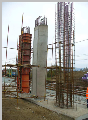
Nadjezd Lukavice - pilíř
