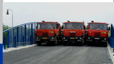
Nadjezd Zvole –zatěžovací zkouška
