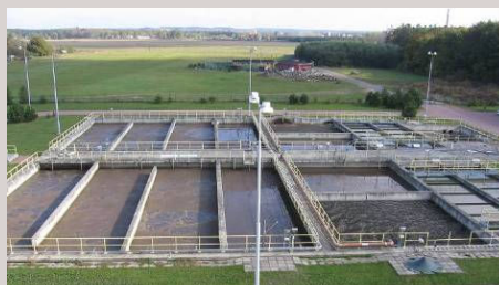
■ Kolín – rekonstrukce ČOV
