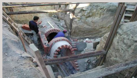
■ Praha – rekonstrukce kanalizace
