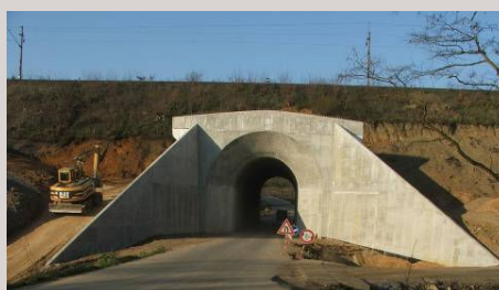
■ Prodloužení mostu v km 366,658 trati Plzeň-Cheb u obce Plešnice
