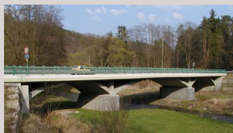
■ Silniční most přes řeku Střelu u obce Borek – Plzeň-sever
