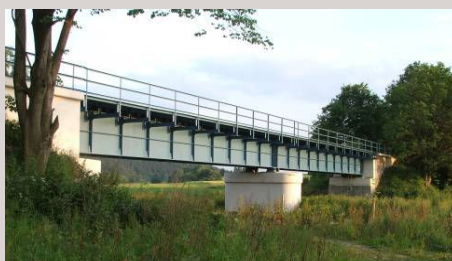
■ Železniční most v km 24,337 na trati Nezvěstice – Rokycany u obce Štáhlavice
