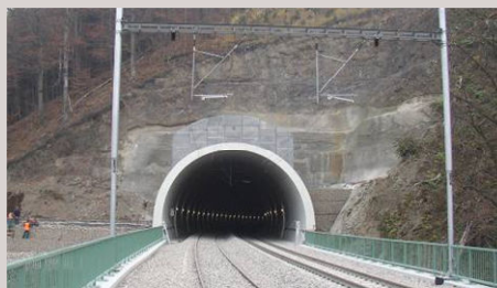
■ Železniční tunel Malá Huba na trati Česká Třebová - Olomouc
