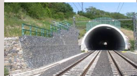
■ Železniční tunel Vepřek, trať Praha/Drážďany
