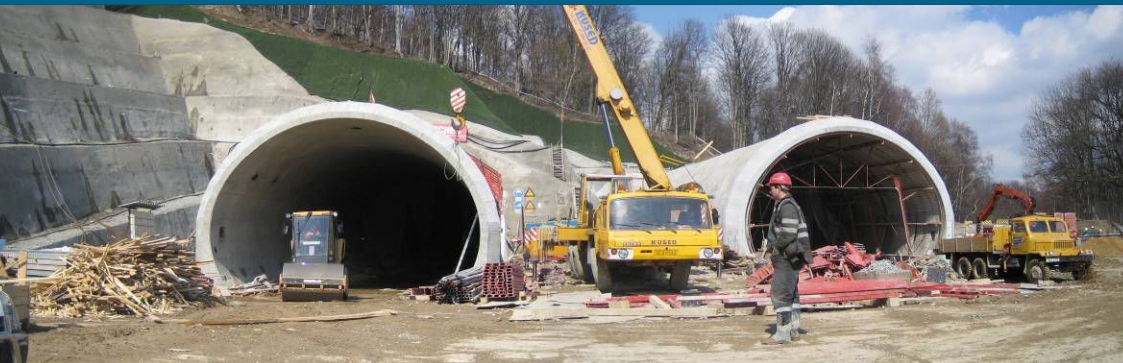
■ Dálniční tunel Libouchec – dálnice D8 Praha/Drážďany
