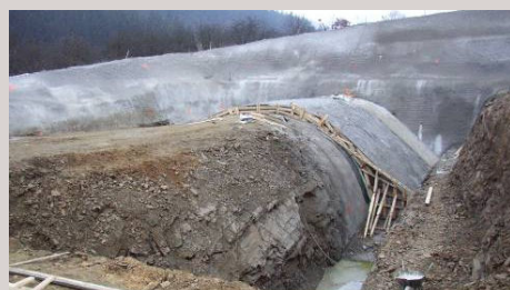
■ Železniční tunel Hněvkov – technologie "želva"
