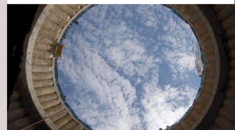
■ Tunel Březno – šachta pro nouzový východ
