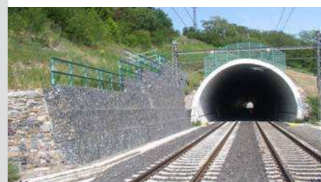
■ Railway tunnel Vepřek, line Prague/Dresden
