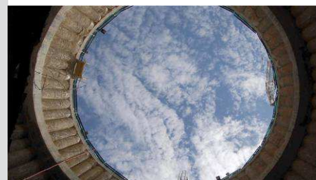
■ Tunnel Březno – shaft for emergency exit
