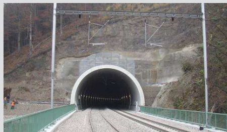
■ Railway tunnel Malá Huba on the line Česká Třebová - Olomouc
